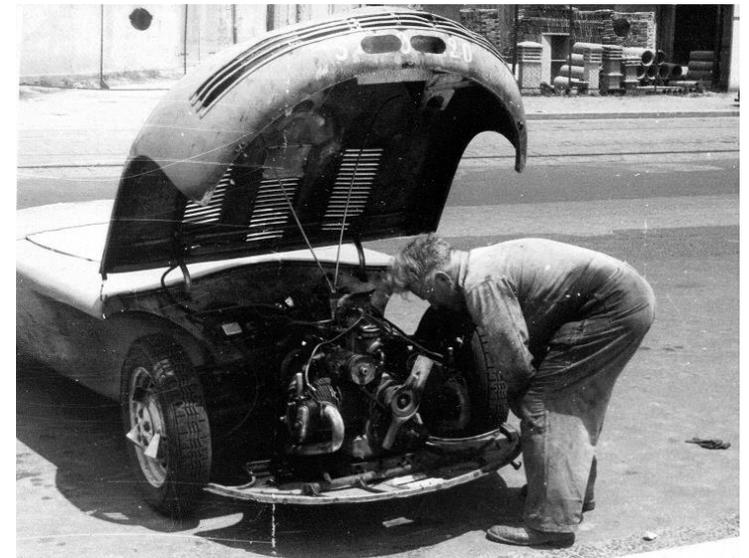
La légèreté constituant l'un des principaux avantages du plastique, la Réac ne pèse pas plus de 460 kg : 375 kg pour le châssis avec son moteur et 85 kg pour la coque.
